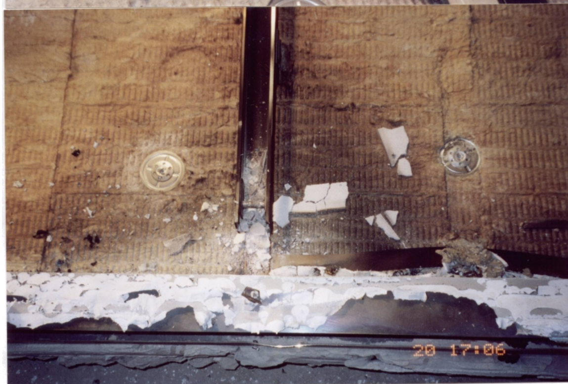
Рис.4.17. Состояние после испытаний минераловатных плит утеплителя и алюминиевых направляющих каркаса, соосных вертикальной оси симметрии образца фасадной системы.
